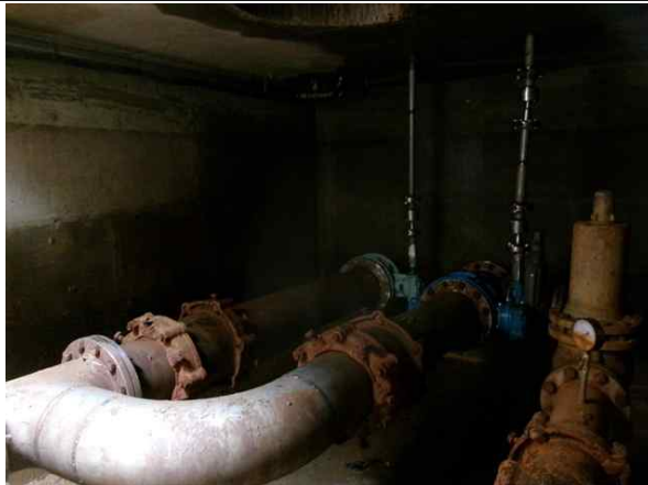
유입밸브실 내부 전경
