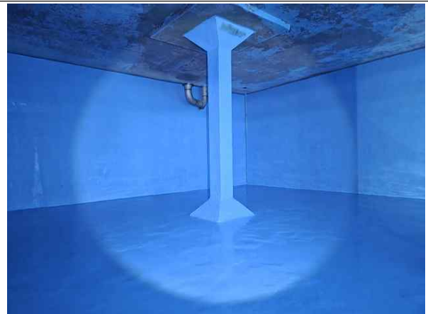
배수지 2지 내부 전경
