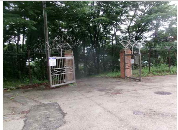
콘크리트 포장 현황
