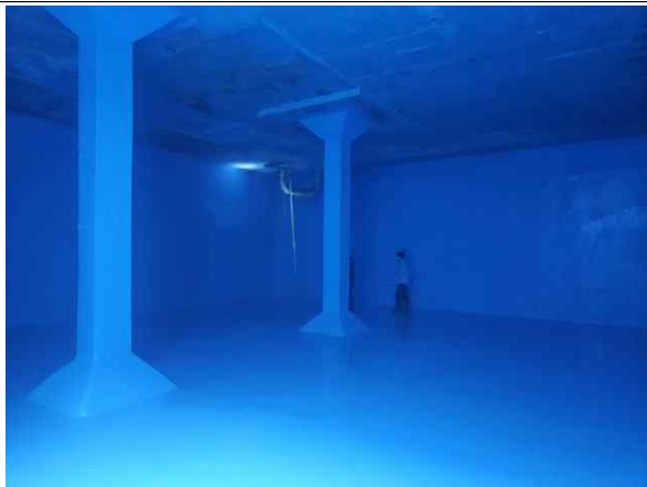
배수지 1지 내부 전경
