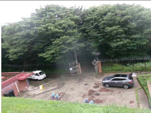
배수지 상부 현황
